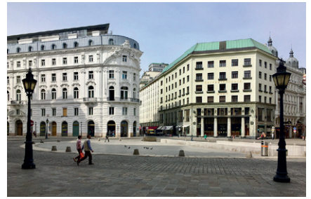
Looshaus, Foto: Felicitas Konecny
