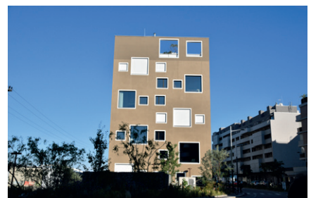
Atelierhaus C21 im Sonnwendviertel
