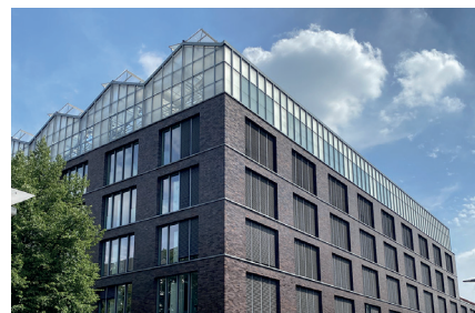
Jobcenter mit Gewächshaus
